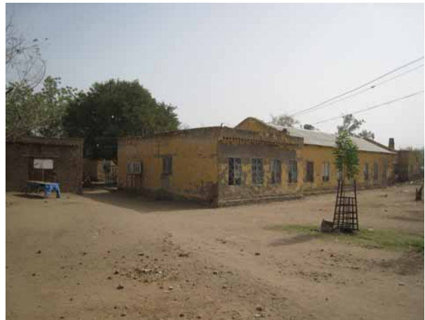
スキ村落病院分娩室外観
