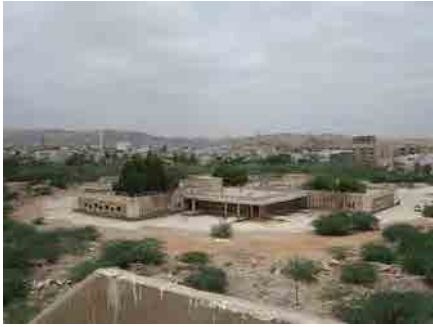
既存のカラチ小児病院全景： 右側が正面ゲート、正面奥がプロジェクトサイト
