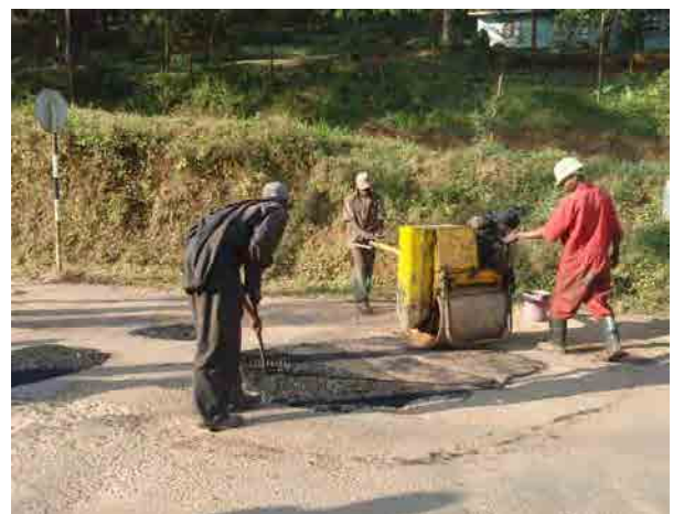
県道の補修工事（Tanga州）
