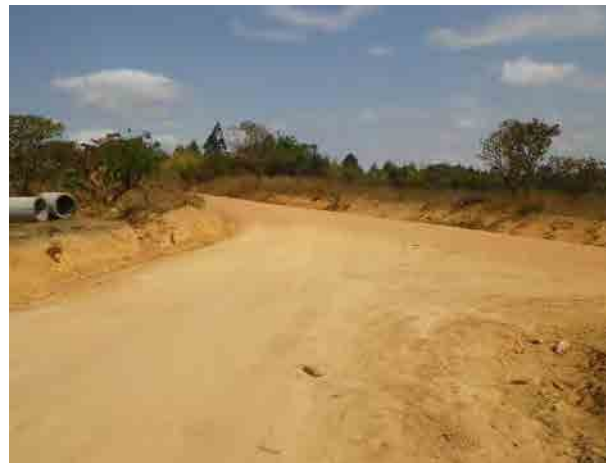
Mfinga県で施工された道路メンテナンス 工事現場（グラベル道路）
