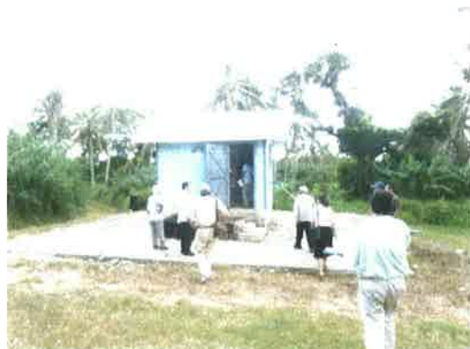
稼働中の井戸
