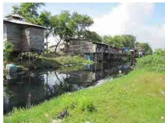
図 B3-27 換気状態が良くない家屋
