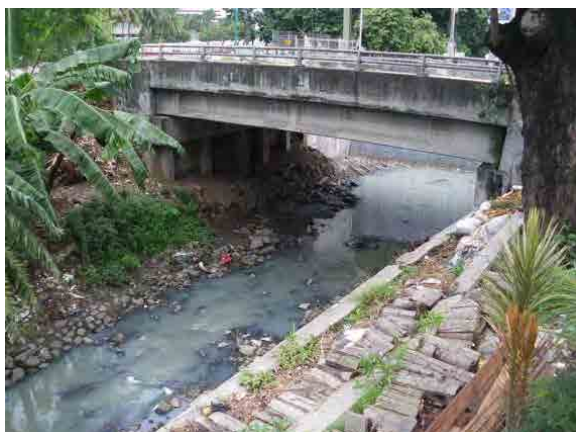
既存スティアブディ下水処理場への流入水路。
