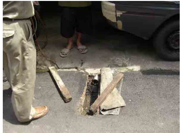
セプティックタンクから雑排水が排水路に流れている様子。
