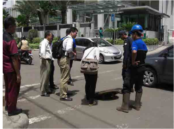
既設下水管路調査の様子。
