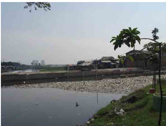
プリーツ調整池に滞留したゴミの状況。
