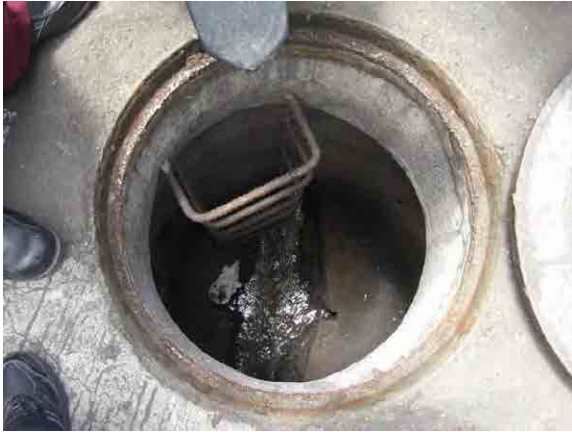
既設マンホールの様子。
