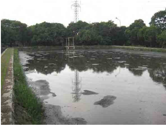
既設Duri Kosambi汚泥処理場。
