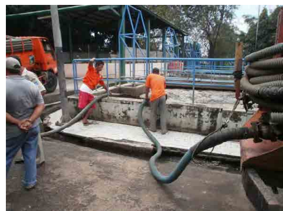
オンサイト汚泥が既存汚泥処理場に搬入されている様子。
