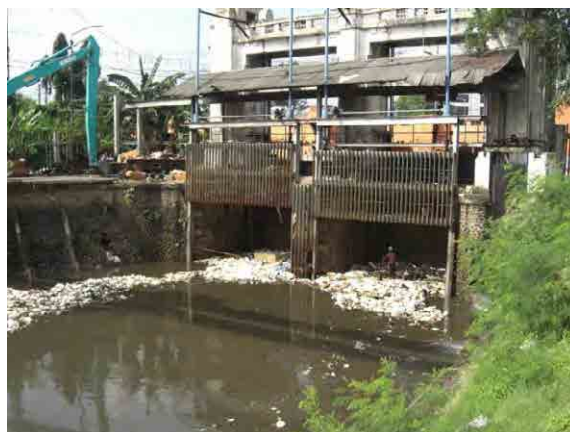
ジャカルタ市内の水門の様子。
