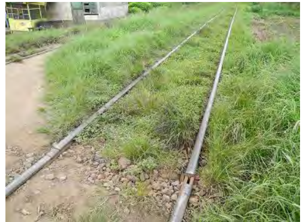
上記箇所の左側の継ぎ目には間隔調整用のレールが挿入されている。
