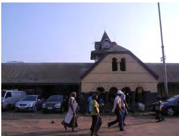
三角屋根のアクラ駅の駅舎
