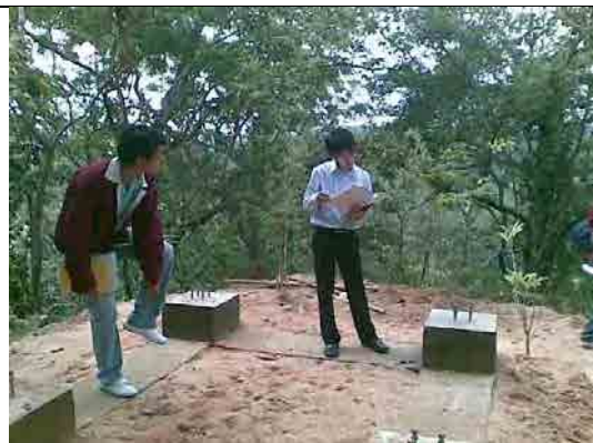
建設中のタワー
