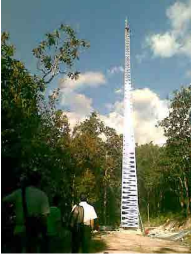
建設されたタワー
