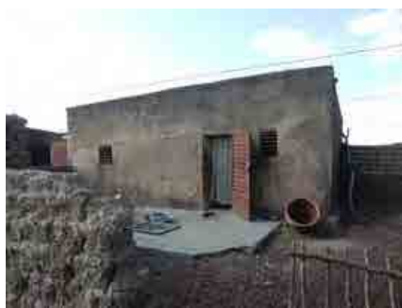
■ Photo-8: Logement pour les agents de santé existant. Le logement constitue une condition indispensable pour affecter les agents de santé aux CSPS.
