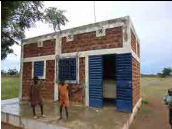
■ Photo-5: Vue d'extérieur de la vente MEG. Le service disposera d'un bloc individuel, construit à l'intérieur du site.
