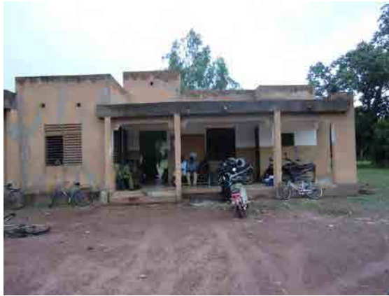
■写真-1：既存一般診療棟外観 ベランダは待合スペースの他、患者家族が宿泊するスペースとしても使用される。
