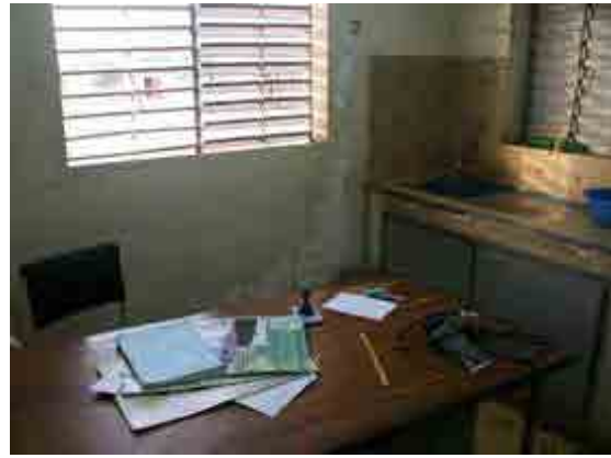
■写真-2：既存診察棟内部 シンクカウンターおよび医療機材。開口部にガラスは無くスチール製ルーバー窓のみ。
