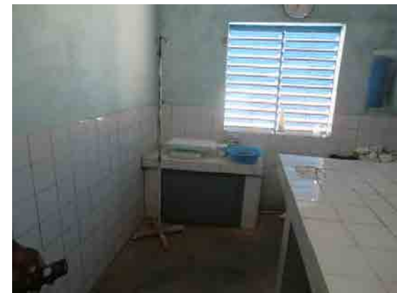
■写真-4：既存産科棟内部 分娩室の腰壁はタイル貼り、上部はペンキ仕上げである。
