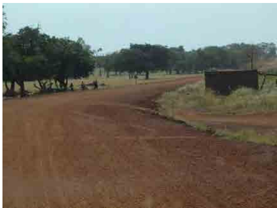
■ 写真-11：対象サイトへのアクセス道路 主要都市間の幹線道路以外は未舗装の道路がほとんどである。
