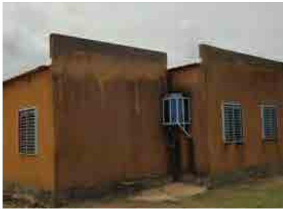
■ 写真-9：外壁に取り付けられた給水タンク 井戸から汲み上げられた水は、人力で給水タンクに注がれる。
