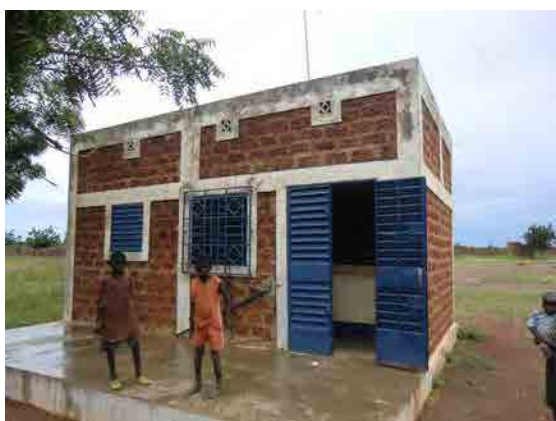
■写真-5：既存薬局販売所外観 独立棟として敷地内に配置される。
