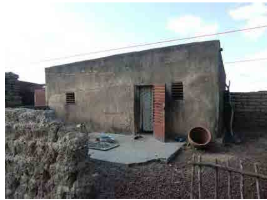
■ 写真-8：既存保健医療従事者宿舎 宿舎は CSPA に保健医療従事者を配属するために、必要不可欠な条件となっている。
