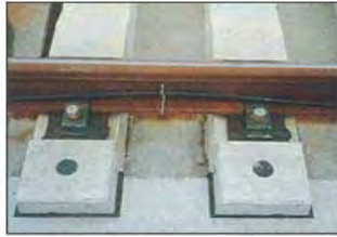
写真 2.3.3.4-1 弾性枕木直結軌道
