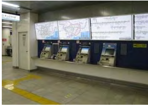
写真 2.3.3.9-2 自動券売機及びチャージ機の例
