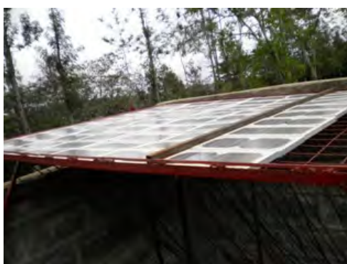
図7-7 ソーラーパネル設置状況
