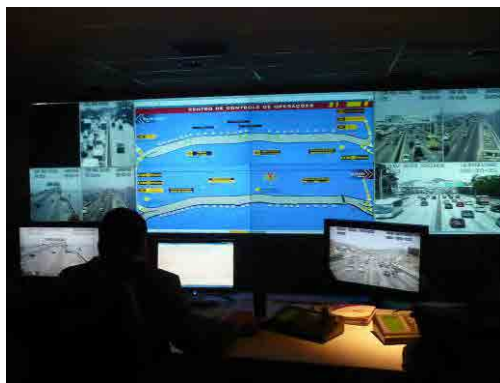
ニテロイ橋管制センター1
