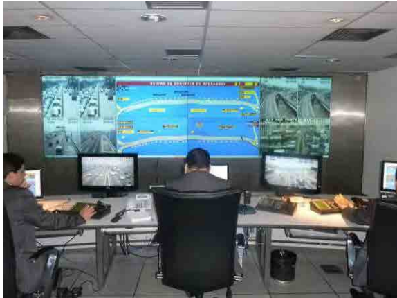
写真 3.2-13 交通管制センター内
