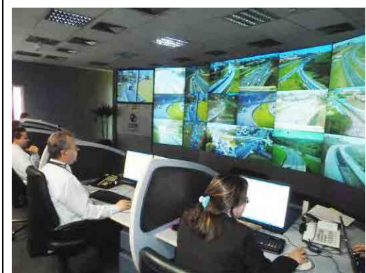
AutoBAn の交通管制センター
