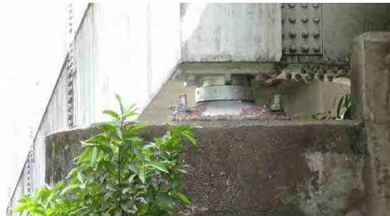
固定側はピボット支承が用いられている。
