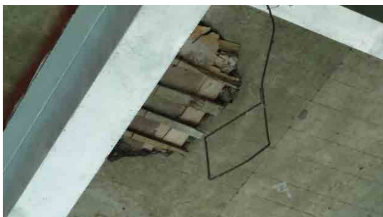
床版部分取替箇所
