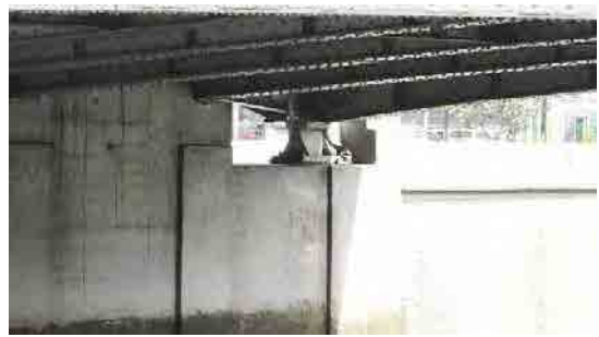
中間支点上。コンクリートブロックによる耐震補強がなされている。
