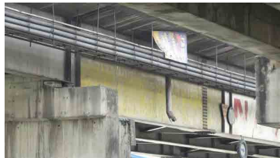
鋼鈹桁で支間の長い箇所桁高変化
