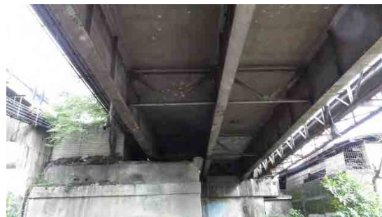
鋼3主桁端部耐震コンクリートブロックの設置状況
