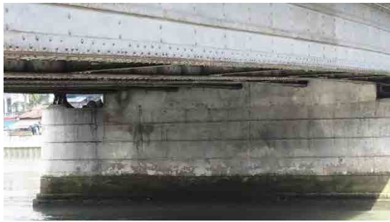
直角方向の移動制限コンクリートブロック設置
