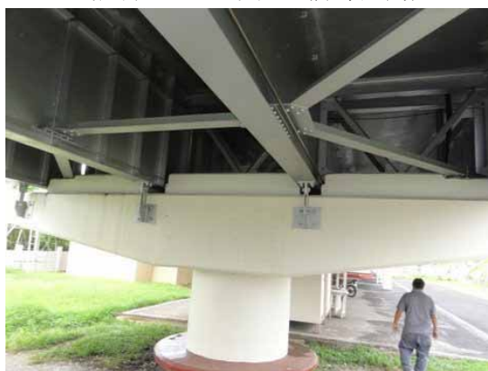
レイテ側桁下の状況 (DPWHの管理区域)
