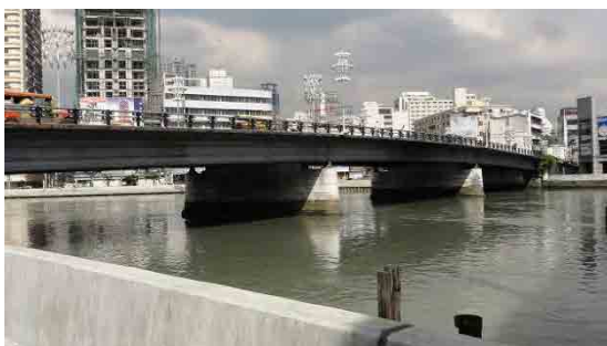
3径間連続鋼桁橋
