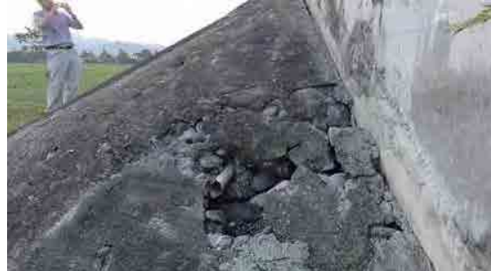
橋台の当初高さから50cmほどずり下がった跡がみられる。 また、沈下の過程でスローププロテクションに損傷が生じている。
