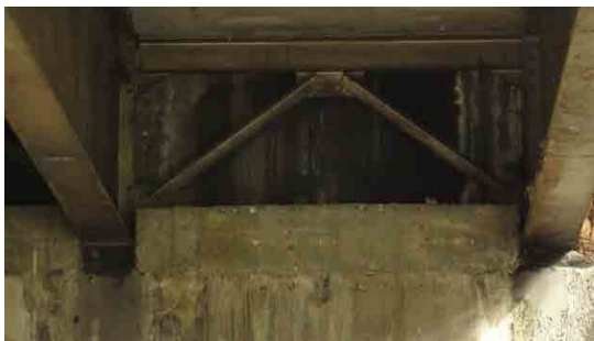
鋼3主桁端部耐震コンクリートブロックの設置状況
