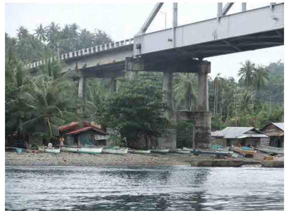
パナオン島側のアプローチ部分桁下
