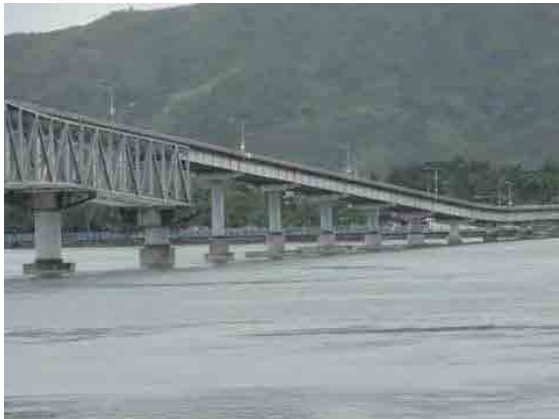
レイテ側桁橋区間
