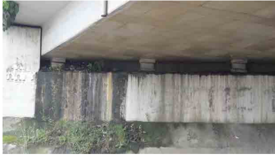
側径間のロッカー支承部
