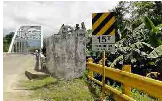
荷重規制15tの標識がある。
