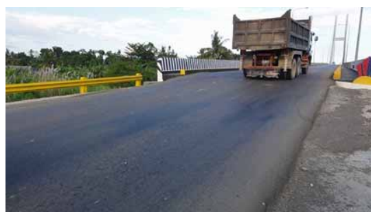
ブトゥアン側の橋梁アプローチ部で著しい沈下が生じている（Depression）。
