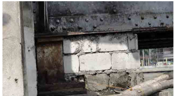
側径間端部の侵入防止ブロック設置
