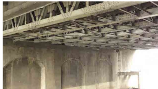
当初鋼トラス桁10本の構成
