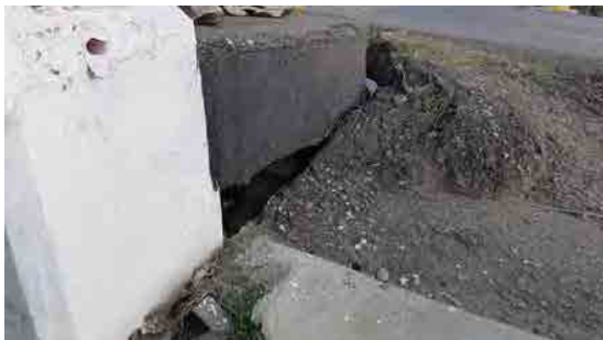
沈下状況と横断方向にわたるスローププロテクション部の大きなクラック発生
