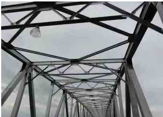
上部構造部材の状態は良い。
