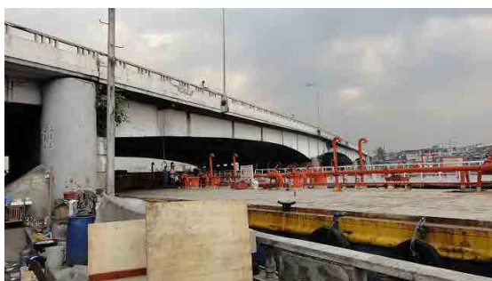
3径間連続PC箱桁橋
