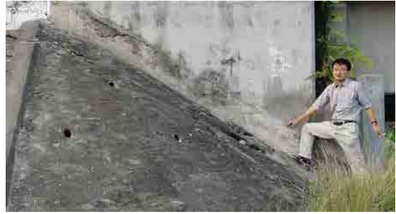
約50cmの沈下がみられる。沈下のためスローププロテクションにクラックやスポーリングが生じている。
