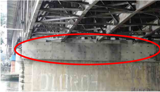
橋脚に追加されたコンクリートブロック
