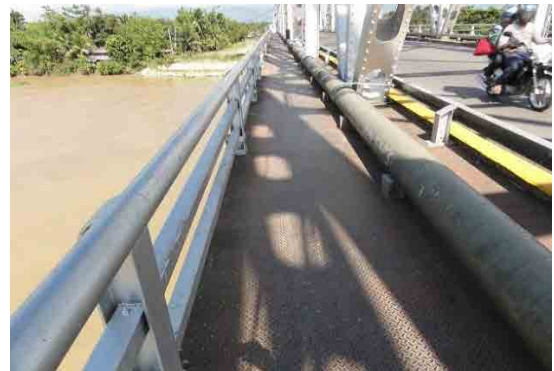
歩道部は縞鋼板であるがよくメンテされている。
