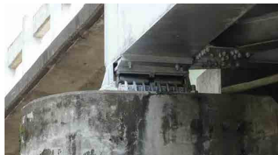
補修済み可動側ピンローラ支承
