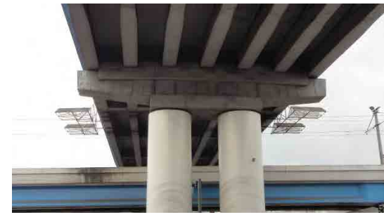
直角方向の移動制限コンクリートブロックが設置済み
