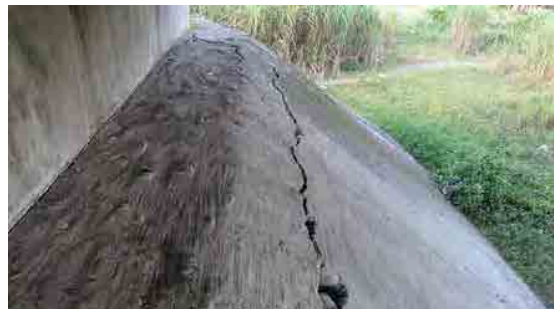
沈下状況と横断方向にわたるスローププロテクション部の大きなクラック発生
