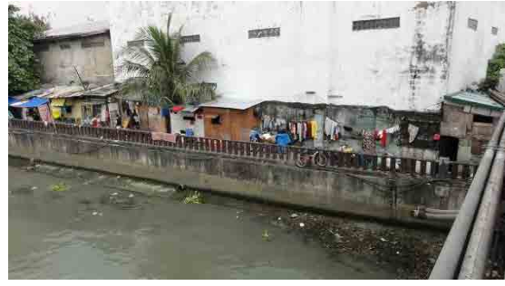
橋台部の状況
