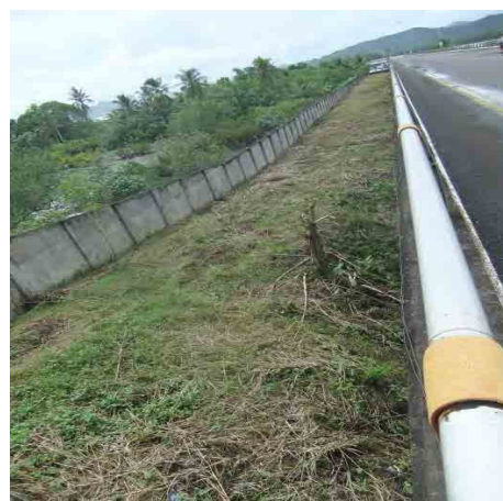
サマール側の橋端部に沿った塀
