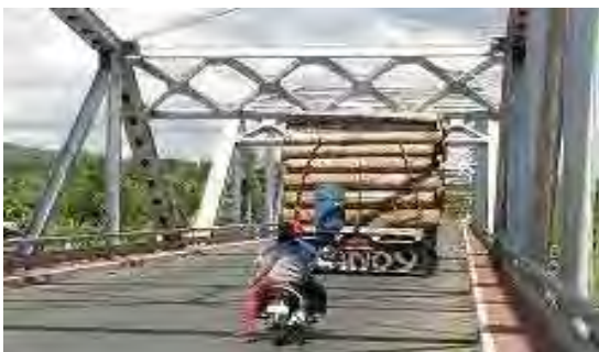
建築限界ギリギリで通過するトラック
