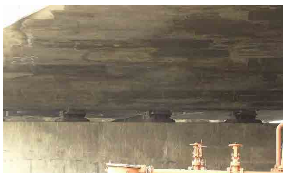
中間支点上鋼製支承
