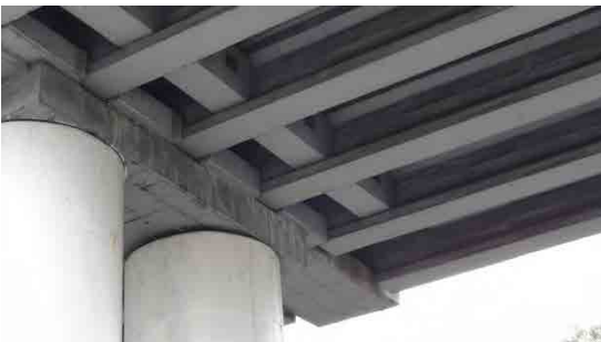
直角方向の移動制限コンクリートブロックが設置済み
