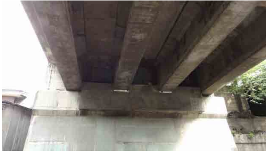
PC4本主桁端部耐震コンクリートブロックの設置状況
