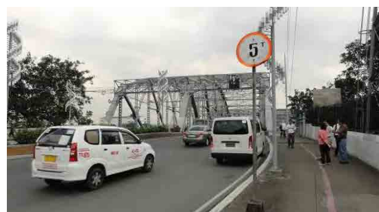
荷重制限5tの標識だが守られていない。
