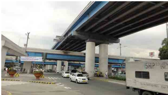
鋼板巻立ての仕上げは良い。
