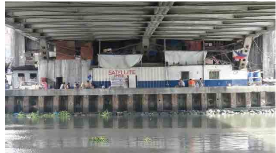
桁下空間の利用状況
