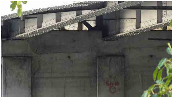
直角方向の移動制限コンクリートの設置
