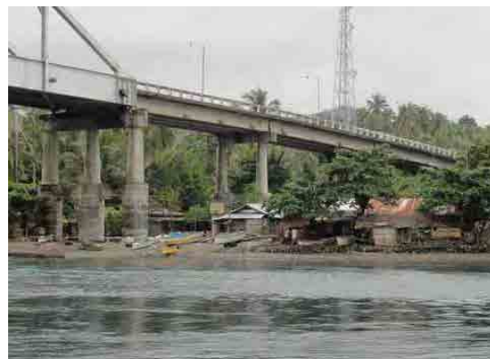
パナオン島側のアプローチ桁橋
