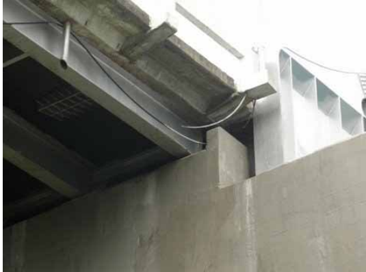
鈹桁橋とトラス橋の橋台構造
