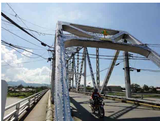
支間長120mのトラスラングアーチ橋
