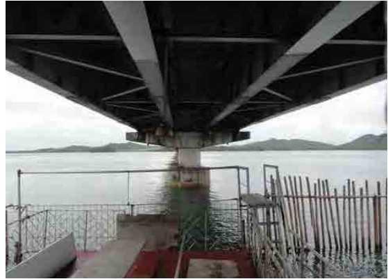
アプローチ桁橋区間は一本柱橋脚（レイテ側） 強震動にはいささか心もとない気もする。
