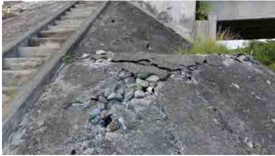
約50cmの沈下がみられる。沈下のためスローププロテクションにクラックやスポーリングが生じている。
