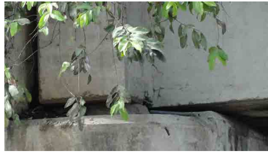
横ブラケット張り出し支承のためクラックがみられる。
