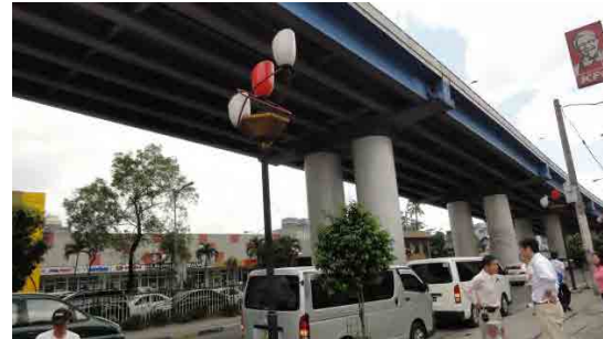
上部工桁連結もなされている。
