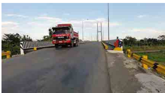
ブトゥアン側の橋梁アプローチ部で著しい沈下が生じている（Depression）。
