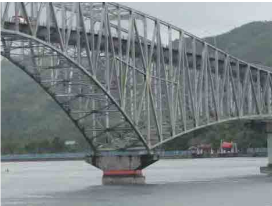
中間支点上支承部（レイテ側）
