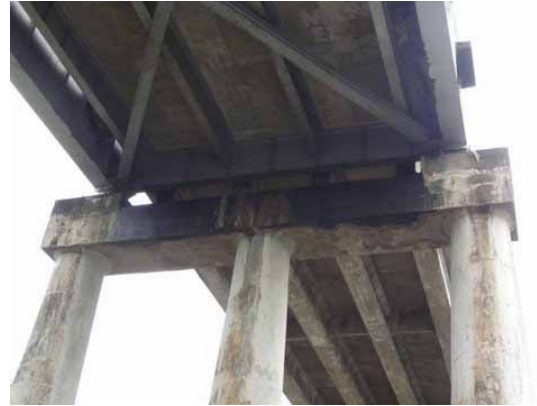
アーチとコンクリート桁の連結部分
