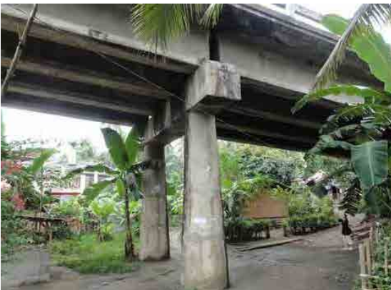
アプローチ桁橋の橋脚（耐震補強なし）
