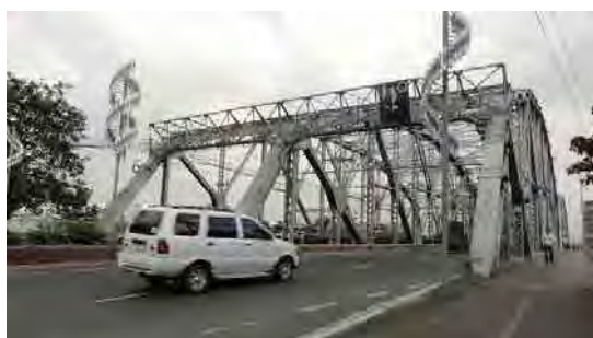
3主構トラス橋
