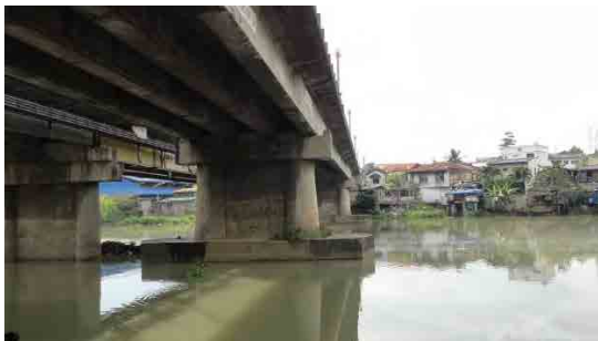
右側PC4主桁、左側鋼鈹桁3主桁
