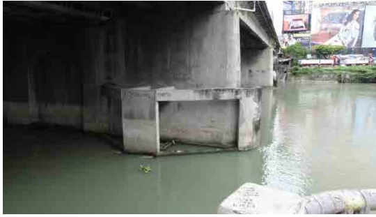
中間橋脚の衝突時緩衝部材設置状況
