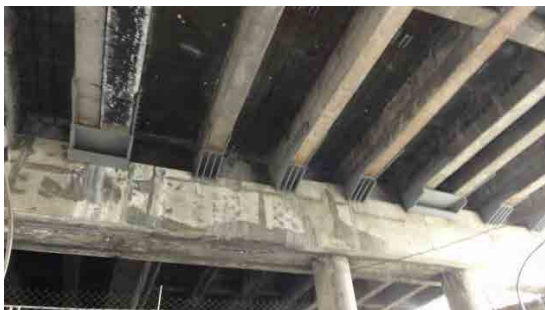
上部工の脱落防止のブラケットが設置済み
