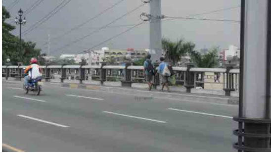
橋面状況は良い。
