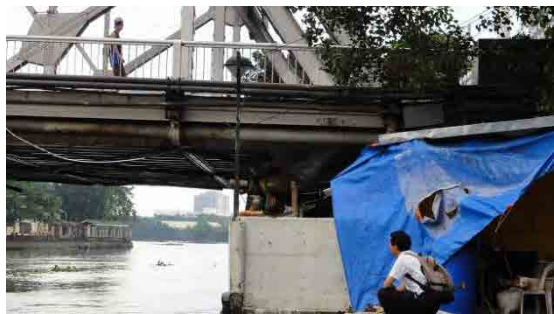
端部状況、人家になっている。
