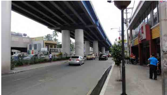
白く塗られた部分が鋼板巻立ての箇所
