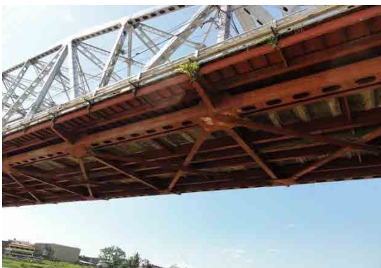
桁下面の下塗り塗装の状況
