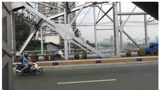
橋面の状態は良い。
