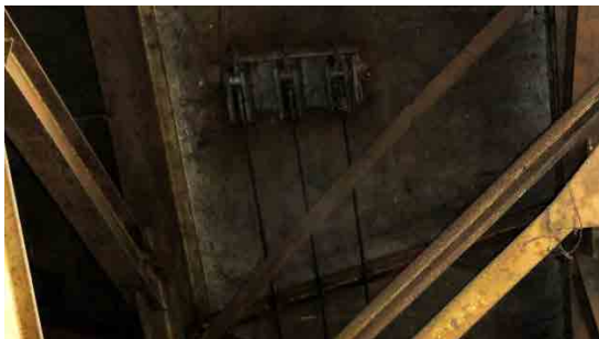
トラス部とアプローチ支間の連結ケーブル
