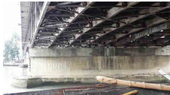
中間橋脚の状況
