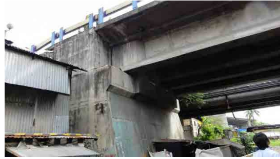
PC4本主桁端部耐震コンクリートブロックの設置状況
