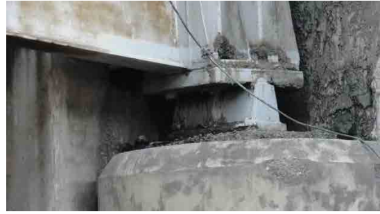
オリジナルのピン支承で移動制限装置はない。
