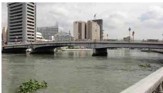
3径間連続鋼桁橋
