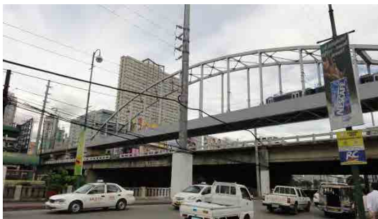
外桁がPCゲルバー桁、中桁は鋼トラス橋
