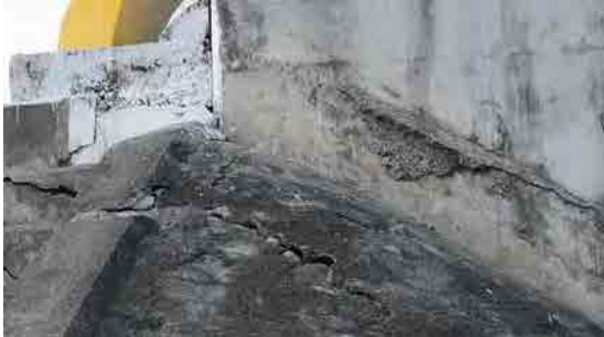
橋台の当初高さから50cmほどずり下がった跡がみられる。 また、沈下の過程でスローププロテクションに損傷が生じている。
