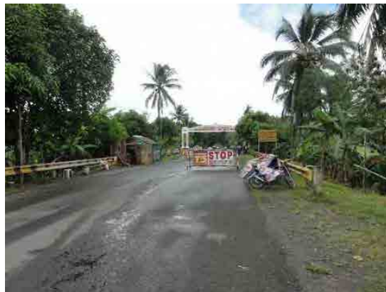
橋の両側にチェックポイントがある。
