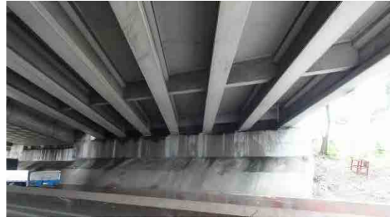
側径間橋台部
