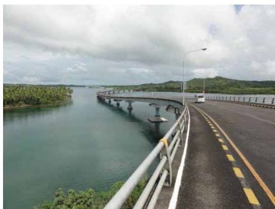
アプローチ桁橋区間 (両岸とも一本柱の橋脚区間)
