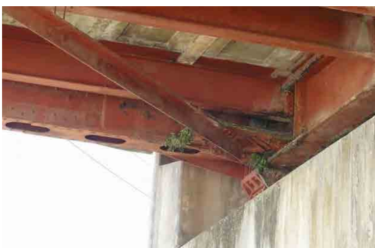
ピン支承がみられる。
