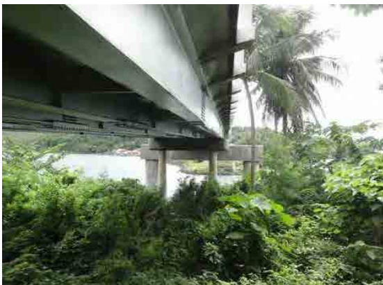
アプローチ桁橋を支える上細りの橋脚
