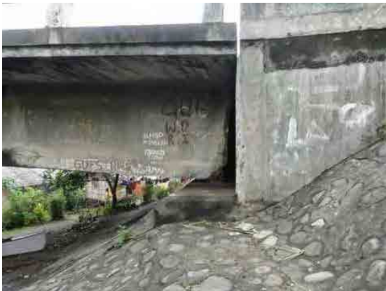
コンクリート桁橋の支承部（パナオン側）
