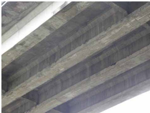
アプローチ橋桁の下部の状況
