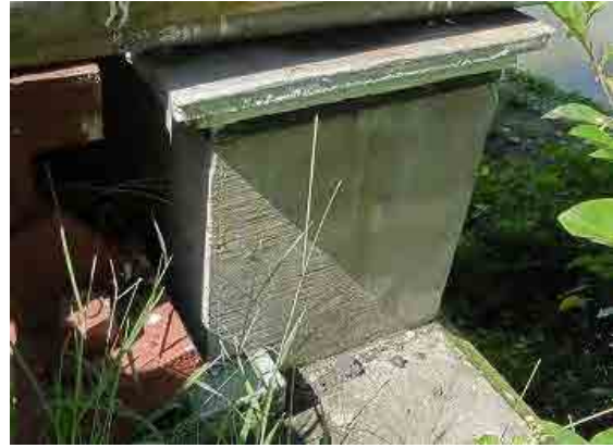
一時的な反力支持のための架台コンクリート
