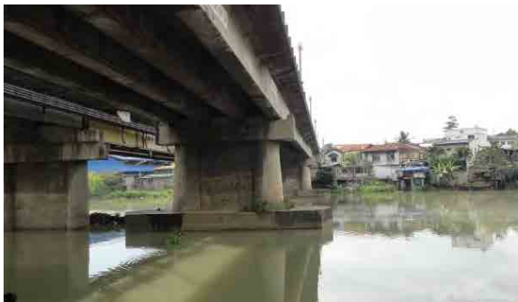
VARGAS 橋は、Marikina 川を跨ぐ道路橋。4 連単純鋼桁橋と拡幅部ゲルバーヒンジ PC 桁橋
