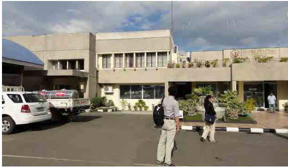
DPWH-Region XIII Regional Office (ブトアン) 施設は比較的新しく、内装、外装の手入れもよく行き届いている。
