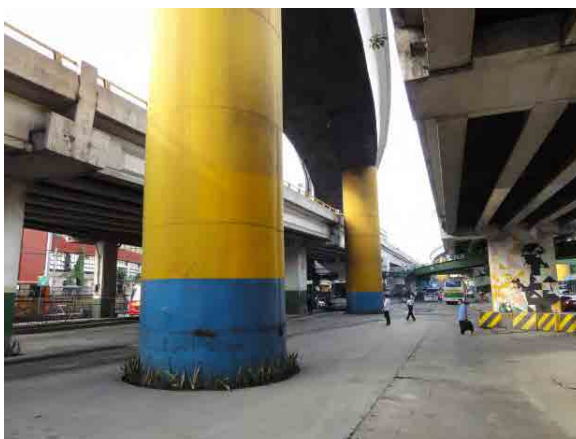
ORTIGAS Flyover は 2005 年ごろに鋼板巻立て補強が実施されている。
