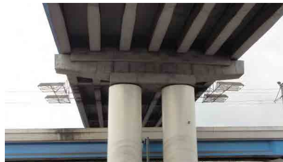
直角方向の移動制限コンクリートブロックが設置済み。上部工は桁連結で PC ケーブルまたは鉄筋が桁内に配置されていると思われる。
