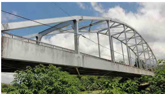
Taguibo 橋はランガーアーチ橋と鉸桁から成る。
