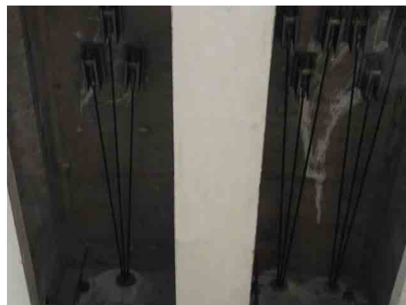
下層部の上部工は PC 桁橋同士が橋軸方向のケーブル等で連結されている。
