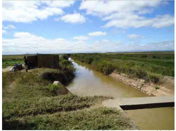
アロチャ・マングル県モデルサイト内の幹線水路
