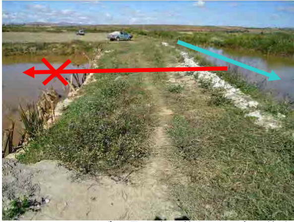
アロチャ・マングル県 水利施設の当座の修復
