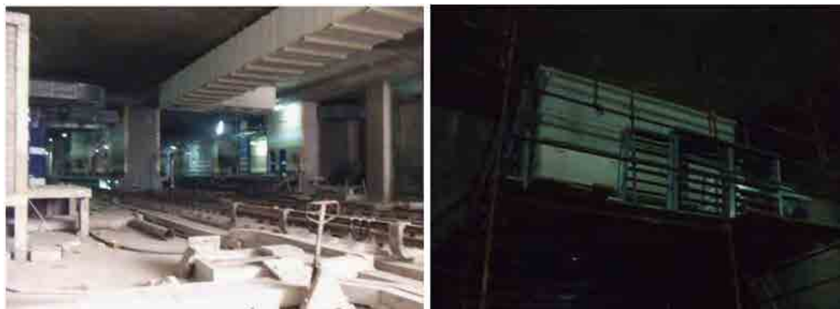
図 2.10 カイロ地下鉄3号線 Abbasseya 駅のプラットフォーム/コンコースの排煙口
