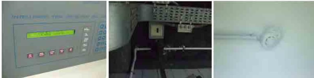
図 2.2.6 火災報知設備(受信盤および感知器)の整備状況(カイロ地下鉄 2 号線 Ataba 駅)
