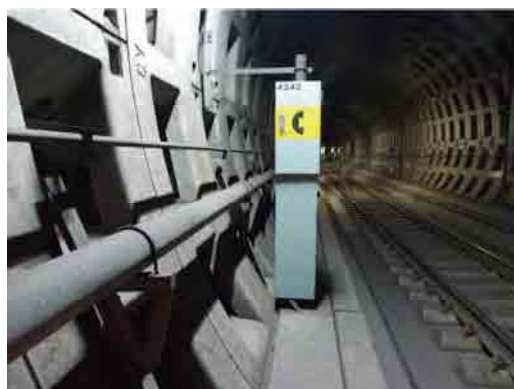
図 2.7 日本における駅間通信設備(沿線電話設備)の設置例
