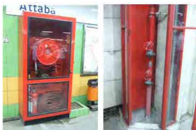
図 2.12 カイロ地下鉄1号線 Sadat 駅の屋内消火栓(左)と連結送水管(右)
