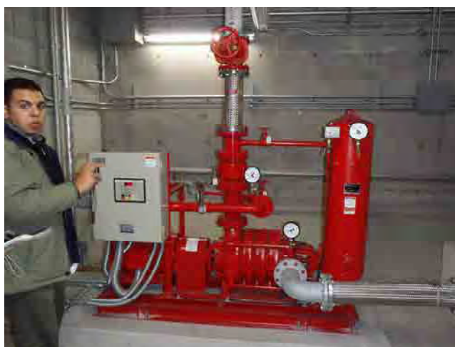
図 3.26 スプリンクラー設備用ポンプ
