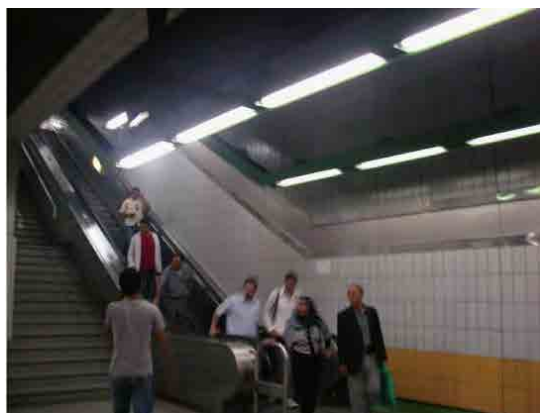
図 2.2 プラットホーム-コンコース間に防煙たれ垂れ幕のないカイロ地下鉄
