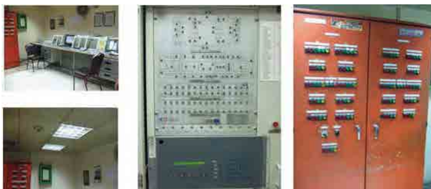
図 2.4 防災管理室(火災受信盤・排煙設備操作盤、カイロ地下鉄2号線 Ataba 駅)
