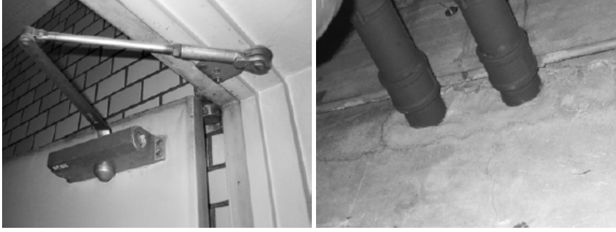
شكل 2-2: فواصل حماية تغلق ابوابها اتوماتيكيا وجميع فتحات الكابلات والمواسير تملأ بمواد غير قابلة للاشتعال
