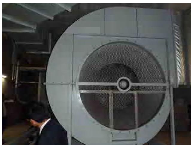
図 3.25 日吉駅のトンネル排煙ファン
