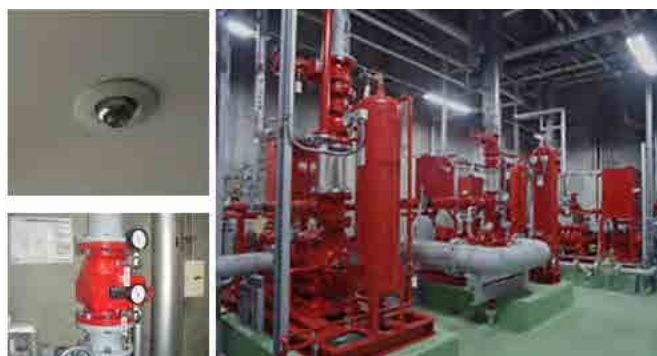
図 2.14 スプリンクラー設備(ヘッド・アラーム弁・ポンプ)
