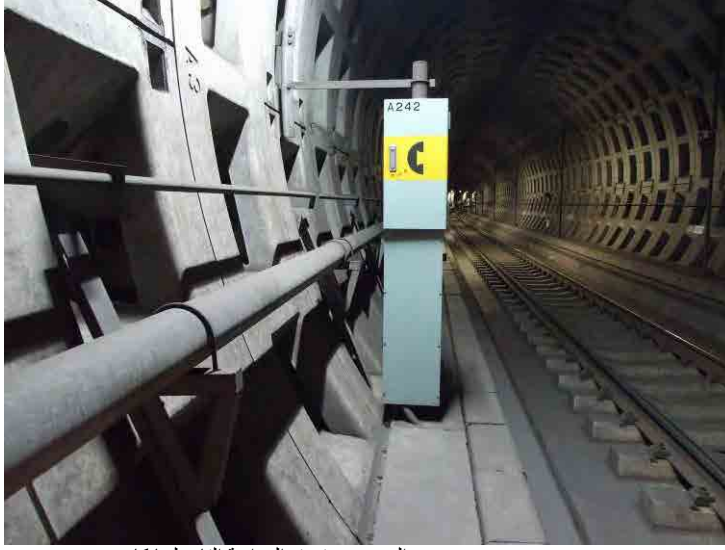
المصدر : فريق الدراسة التابع لجايكا شكل 5-5 نظام الاتصال داخل النفق
