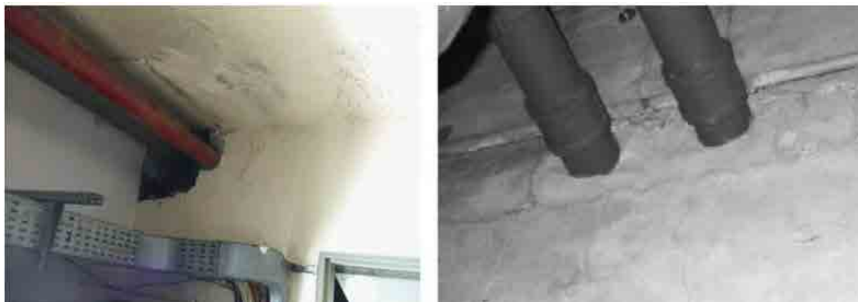
図 2.1 カイロ地下鉄における防火/防煙区画の未形成事例(左)と日本における貫通部処理事例(右)
