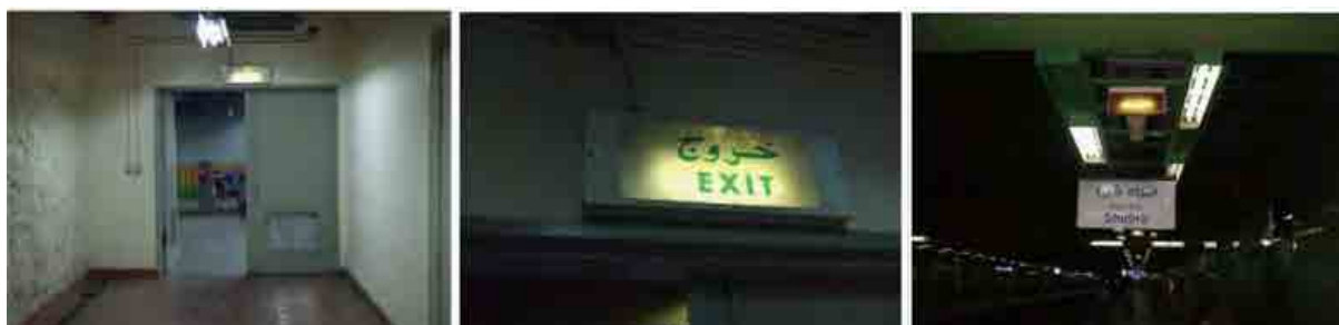
図 2.8 カイロ地下鉄1号線 Sadat 駅における避難口誘導灯と非常照明設備
