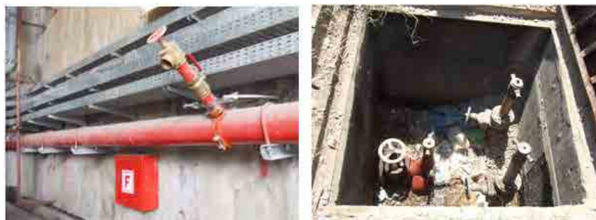
図 2.13 カイロ地下鉄3号線 Abbasseya 駅の駅間連結送水管(左)と1号線の連結送水管口(右)
