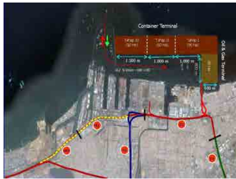
Gambar 2.2-1 Pembangunan Terminal Kontainer di Kalibaru Utara Tanjung Priok
