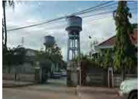
カンポット既設浄水場 高架タンク
