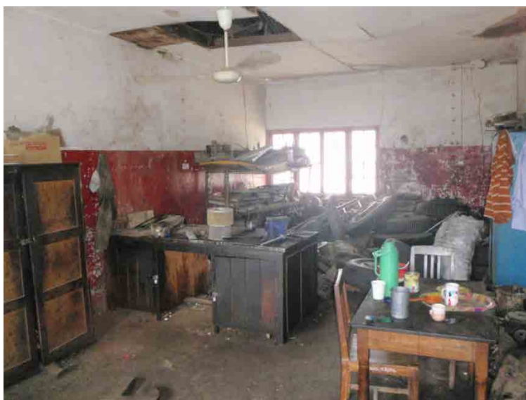
写真 4-2 TEMESA-Dodoma 修理工具保管室
