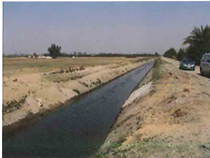
共同補修作業によって補修された用水路 (Ras El Gharbi)
