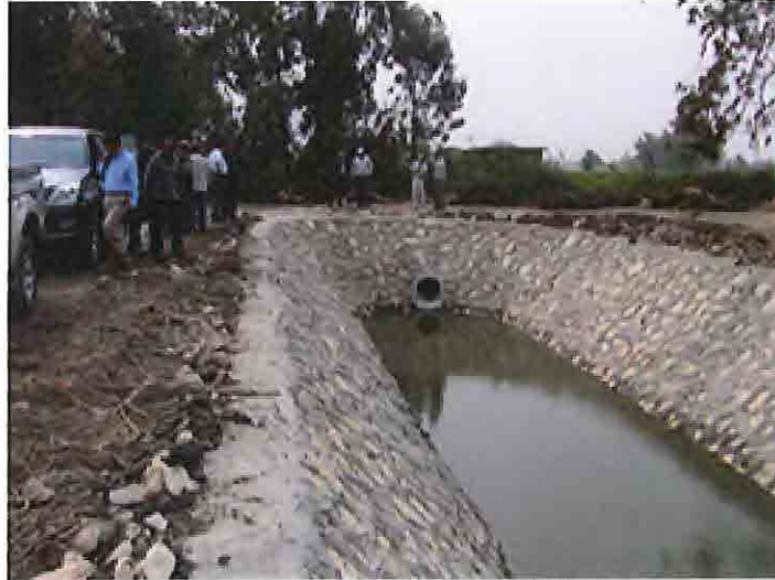
共同補修作業によって補修された用水路 (Bahr El Nur)
