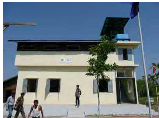
Kwa Kwa Ka Lay CF 普及センター 事務所兼避難施設
