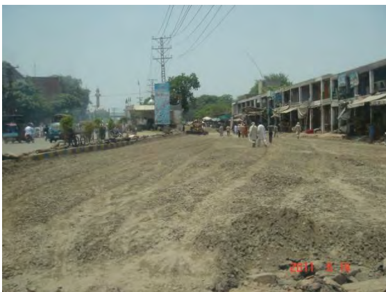
建設中の道路
