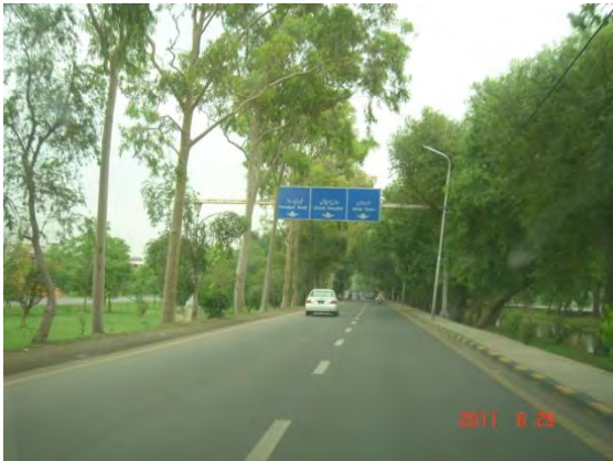
運河道路 (BRT 2 号線整備候補道路)
