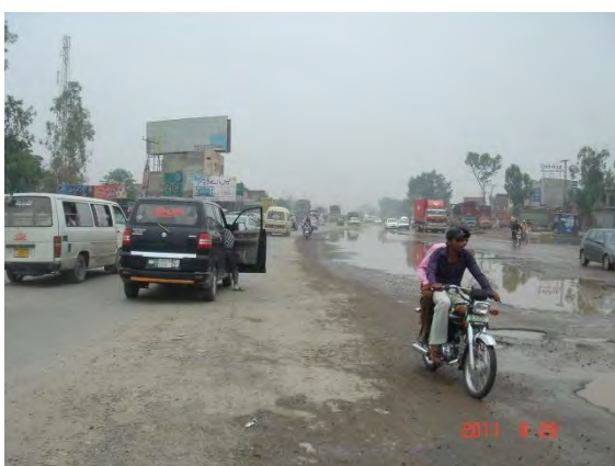
グランドトランク道路 脆弱な維持管理状況
