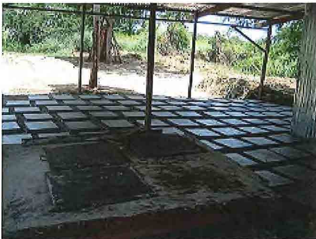
水路に使用するコンクリートパネル（Mbalangwe 灌漑 スキーム）
