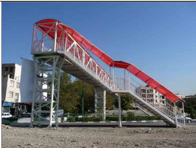
歩道橋。同じタイプの歩道橋が多数設置されている。落橋した場合には多数の障害となるため、耐震性の確認が必要。
