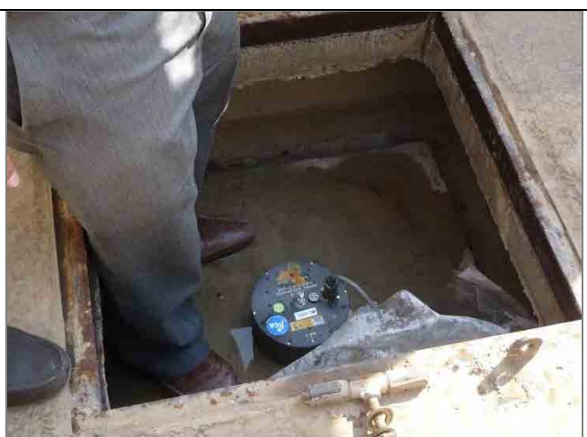
先行プロジェクトで設置した QD&LE システム用の地震計。
