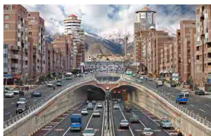
トヒッド・トンネル
