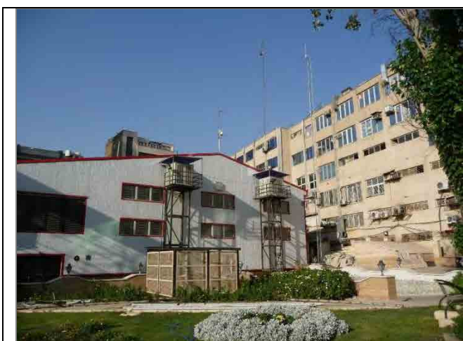
第 12 区の防災拠点。備蓄倉庫や指揮所、非常電源などが備えられている。手前の檻の中に QD&LE システム用の地震計がある。
