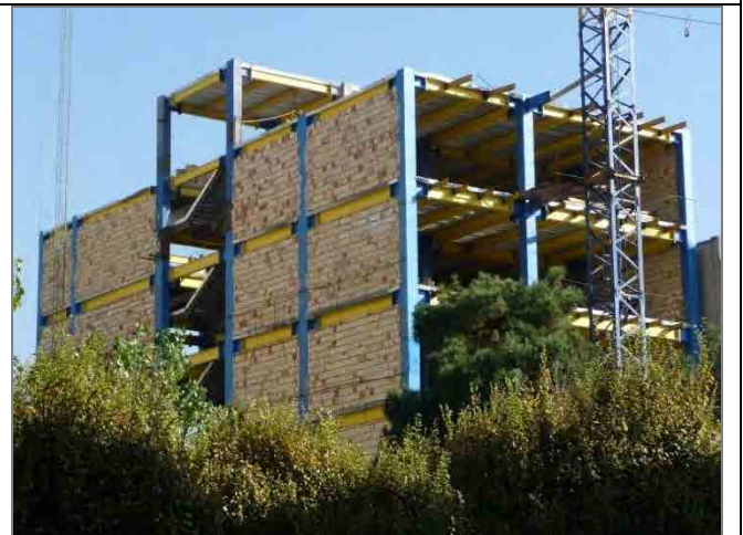
建築中のビル。ビルは鉄骨でフレームを組んでいる。
