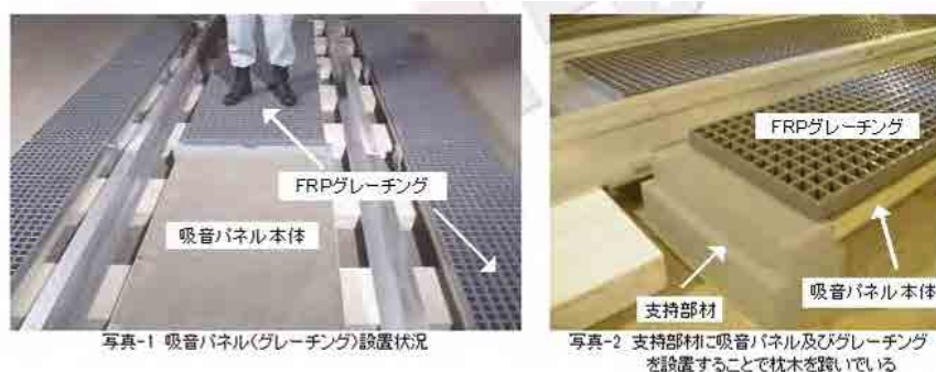
図 3-12 スラブ軌道の騒音対策の例（1）
