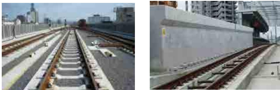
図 3-12 スラブ軌道の騒音対策の例（1）
