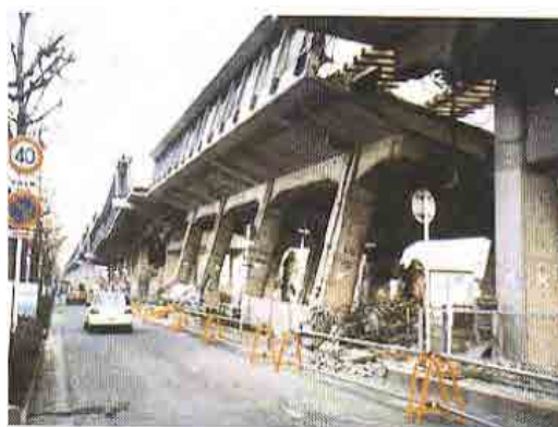
図 3-14 阪神・淡路大震災(1995 年)における山陽新幹線の高架橋の倒壊状況
