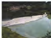
ダム湖のオイルフェンス設置状況
