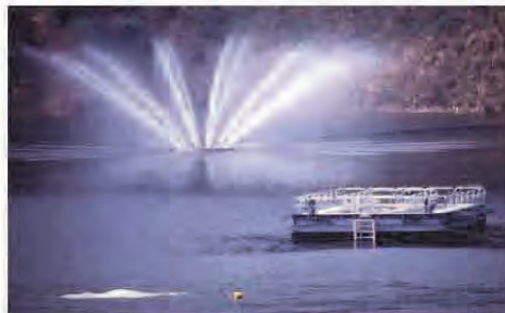
深層曝気、浅層曝気循環、表層循環を組み合わせた対策（布目ダム）
