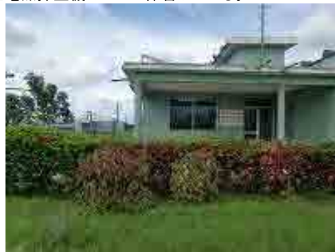
水資源技術総合センター (CITA) 外観。カマグエイ市郊外にあり、本プロジェクトオフィスは CITA 内にある。
