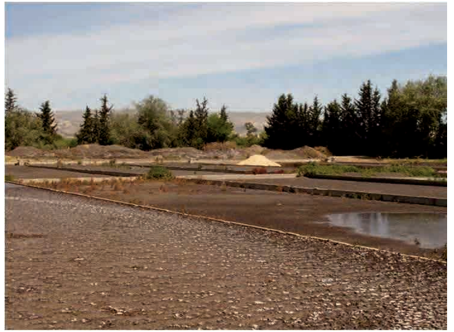
Accumulation d'eau dans les lits de séchage (STEP de Medjez el Bab)
