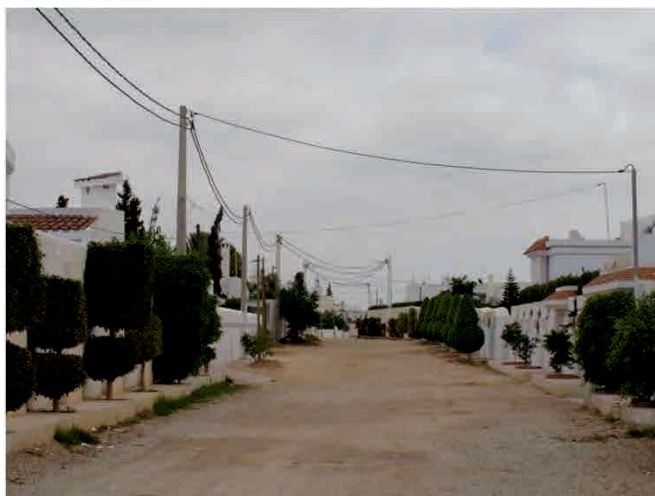
Zone urbanisée dépourvue d'assainissement (Sfax)
