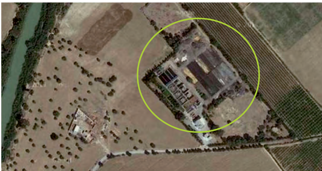
Figure 3.4-1 : Vue aérienne de la STEP de Medjez El-Bab
