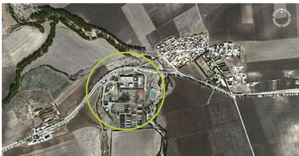
Figure 3.3-1: Vue aérienne de la STEP de Béja
