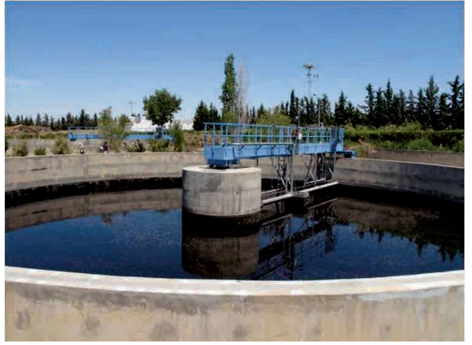
Décanteur de plan circulaire réparé (STEP de Siliana)
