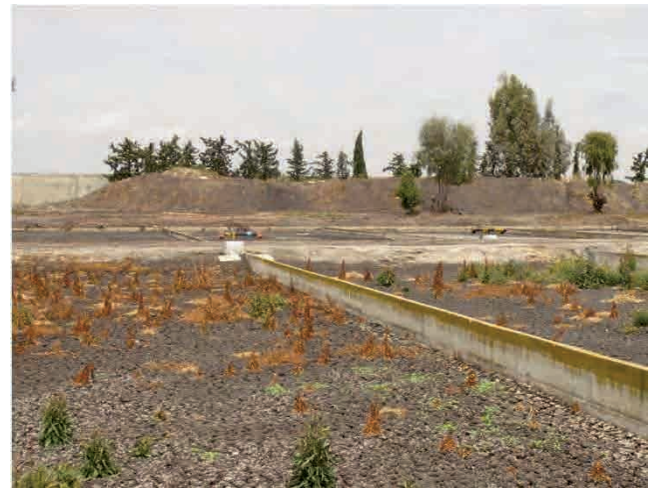
Boues stockées à l'intérieur de la STEP (STEP de Jendouba)
