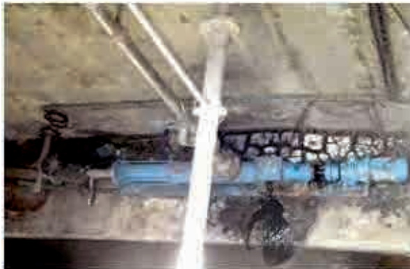
Pompe d'extraction des boues épaissies
