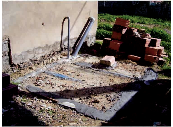
Septic tank (Bizerte)
