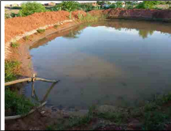
No.7 ゴデ市給水システム 民間水事業者 シェベレ河川水を引き込み、ここで泥質を沈殿させる。塩素消毒は行わずに給水する。
