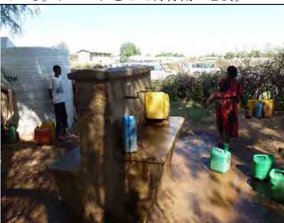
No.6 ジャラル溪谷給水システム 共同水栓 水は給水車で運び奥の貯水タンクに受水された後、キャンプの難民が使用している。
