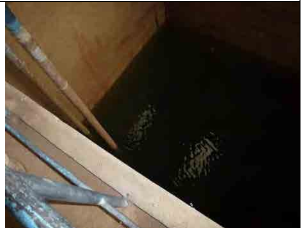
No.10 ゴデ市給水システム 浄水池 ここで塩素を注入して配水池に送水する。浄水処理が適切でないため、濁度が高い。
