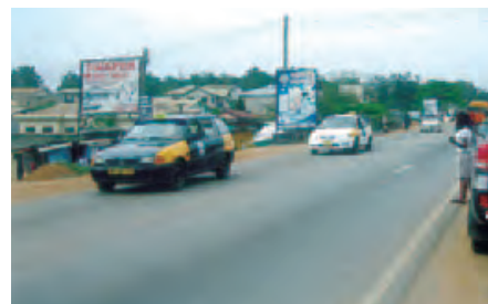
幹線道路セクター投資計画で整備された道路。クマシ〜ケープコースト間で最も交通量が多い
