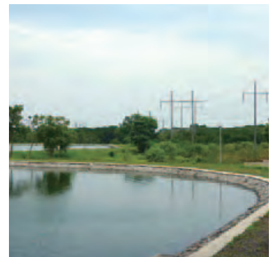
下水処理場の安定化池
