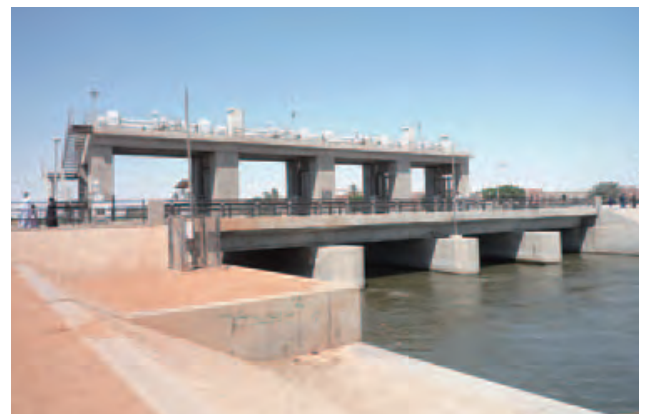
改修されたサコーラ堰(エジプト)
