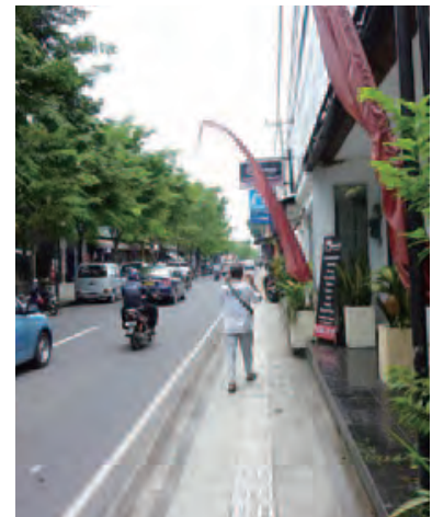
下水敷設エリアの様子(商業地域)
