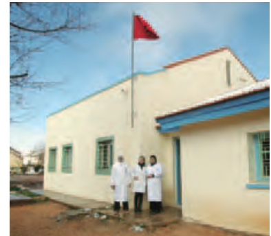
無償資金協力で整備された保健センター。本プロジェクトは、無償資金協力で整備された設備や機材の有効活用にも寄与している
