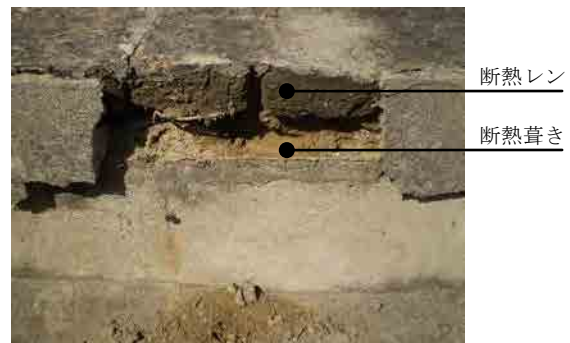
写-2 屋根の断面が見える状態
