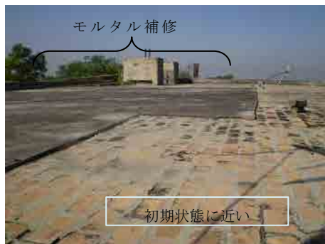
写-1 屋根の状態
