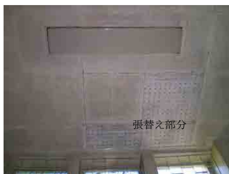
写-3 天井の張替え状況
