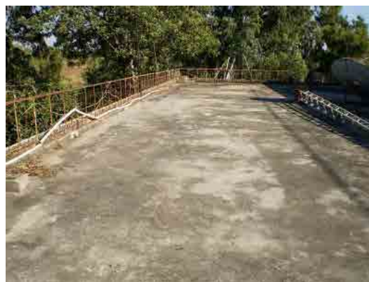
ファキラバード送信所建屋の屋根
