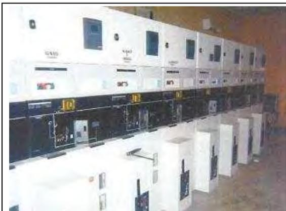
電気室内の11kV配電盤。既設の11kV配電盤の右端に新しい配電盤を設置し、太陽光発電システムと接続する。
