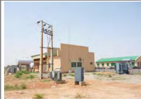
大学用 33kV 配電線の引込柱と電気室。
