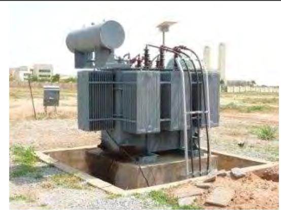
33kV/11kV 変圧器 (5MVA)。現在 33kV で引き込まれている配電線の降圧変圧器として利用されている。
