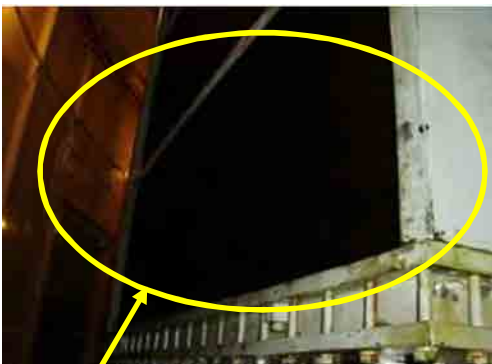
エアクーラのフィンにオイルミストにより油気有り Photo 47
