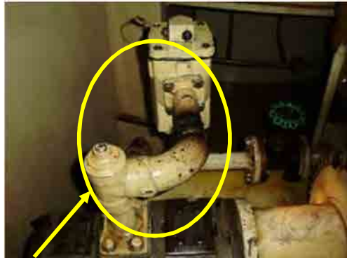
ポンプ交換に伴い配管改造して低圧フィルタに接続 アーク溶接で作業しているので異物が懸念 Photo 20
