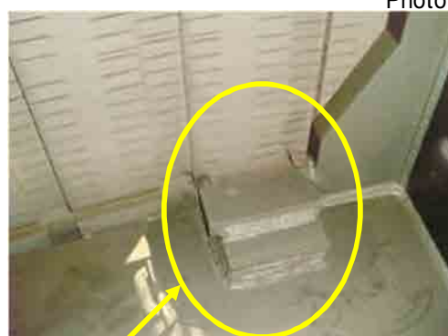
図示外シール作業員ロータリム受け溶接状況 Photo 56
