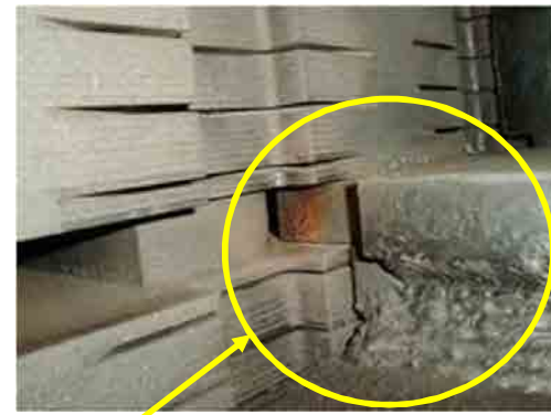
図示外シール作業員ロータリム受け溶接状況 Photo 54
