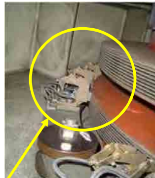
コレクタリングとブラシホルダ 間隙間状況 Photo 62
