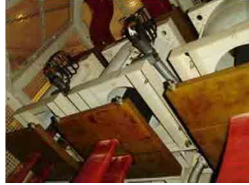
ニュートラルリードとCT:目視点検:良 Photo 30
