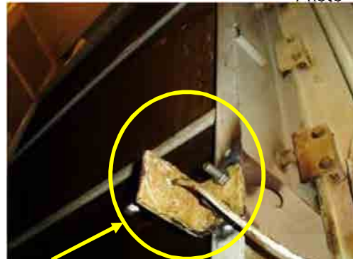
エアクーラ用出口温度計取付状況 Photo 48
