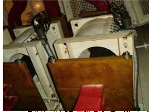
ニュートラルリードとCT:目視点検:良 Photo 28
