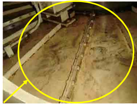
オイルダム下のブラケット内カ-油溜りはなし油気有り Photo 46
