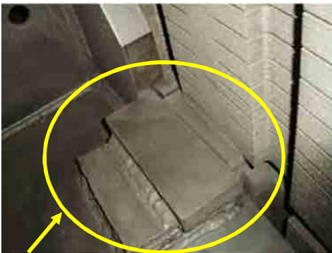
図示外シール作業員ロータリム受け溶接状況 Photo 55
