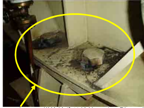
ステータベース増締付ボルト溶接ロック Photo 26
