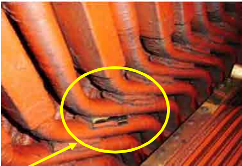
ステータコイル間フィットスペースのクラックと飛散部 Photo 13
