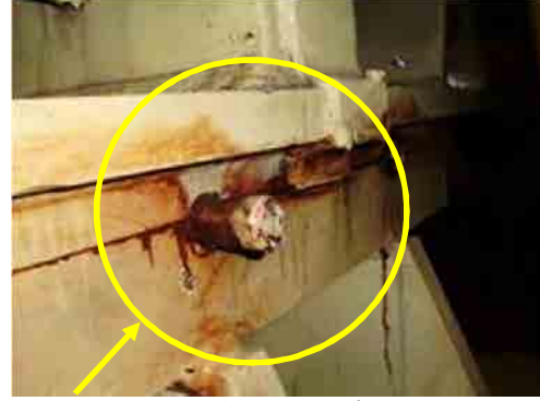
ステータベース ラジアルロックピン拔出し(24本中一本) 拔出し寸法40mm Photo 32
