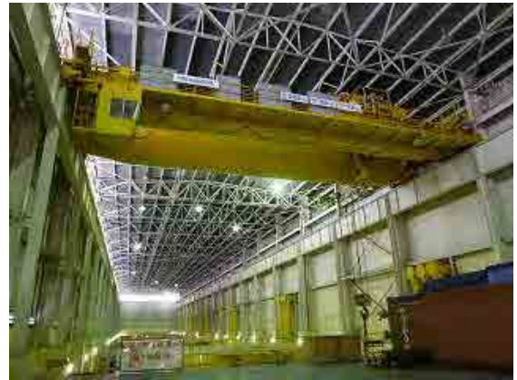
発電所内（クレーン）
