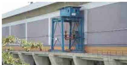
写真⑦ 出口水門ゲート（ドラフトゲート）及び門形クレーン（ガントリークレーン）
