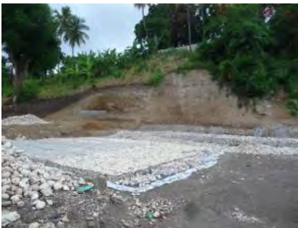
写真 2-3 切土した崖及びふとん籠構 《C》
