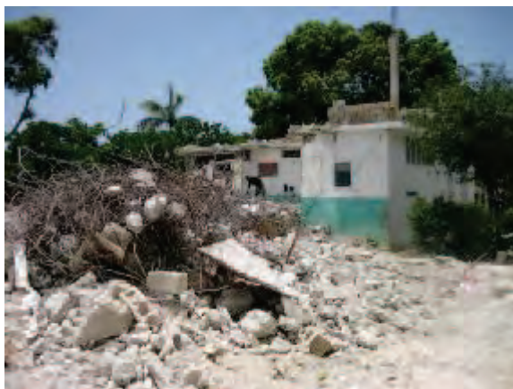
写真 2-5 全壊した内科病棟跡 (2010.6 撮影)
