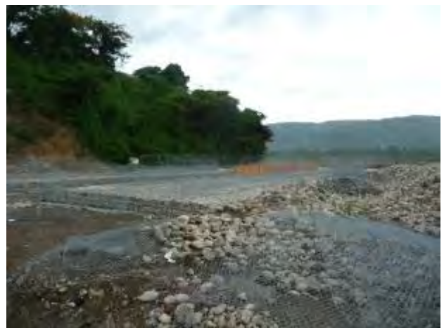
写真 2-4 河床のふとん籠構の敷設状況 《D》
