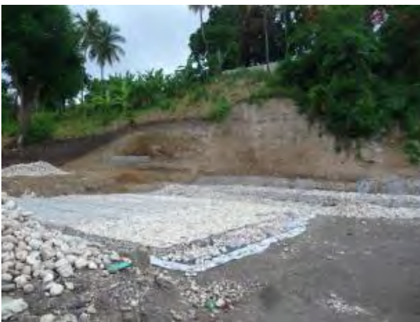
写真 2-3 切土した崖及びふとん籠構 《C》
