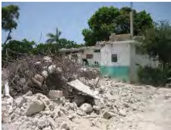
写真 2-5 全壊した内科病棟跡 (2010.6 撮影)
