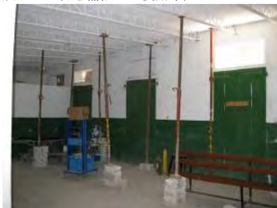
外科病棟：梁が損傷している
