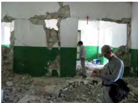
手術棟（震災で建物の半分が崩壊、残りの建物を補強して使用中）
