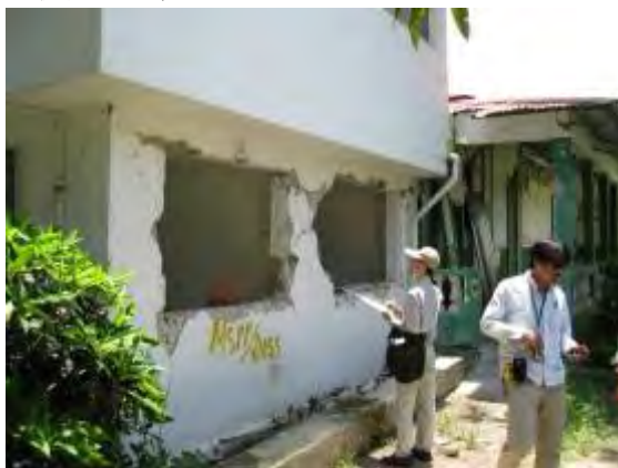
手術棟（震災で建物の半分が崩壊、残りの建物を補強して使用中）
