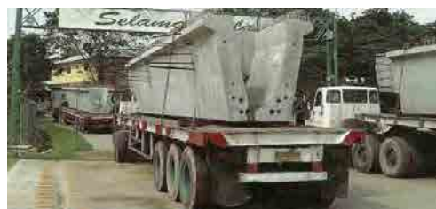
写真-2: PC-U 桁の輸送
