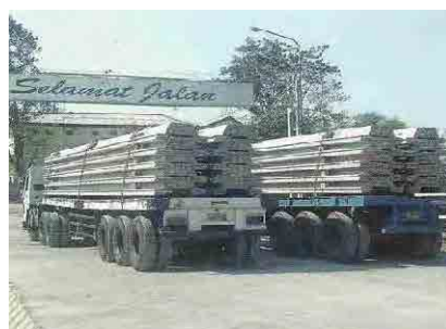
写真-6: PC 矢板の輸送
