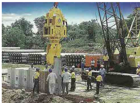
写真-7: PC 矢板打設
