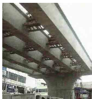
写真-4: 横桁の型枠作業
