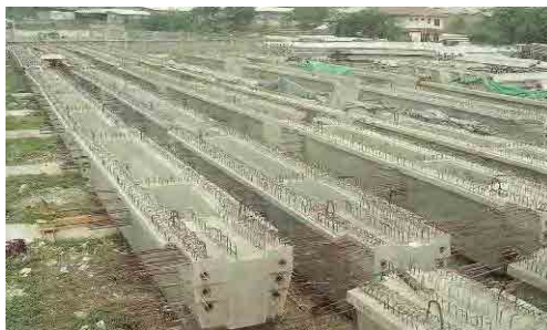
写真-1: PC-U 桁
