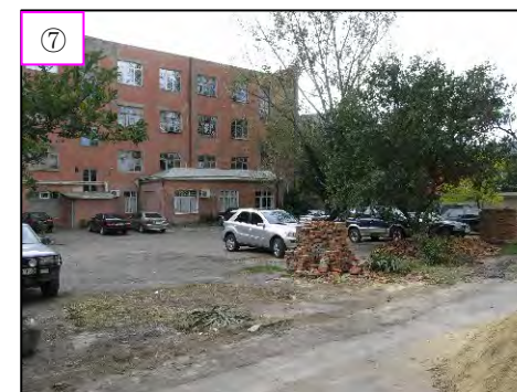
⑦ イリア国立大学 4階建て校舎の駐車場周辺の建物による影の影響がある
