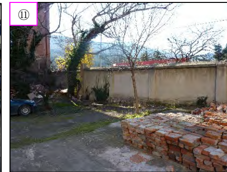
パネル設置予定地の裏側 奥の塀は撤去予定である
