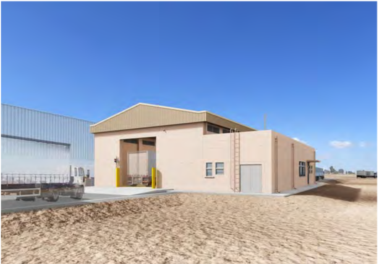
大型貨物車両用X線検査建屋
