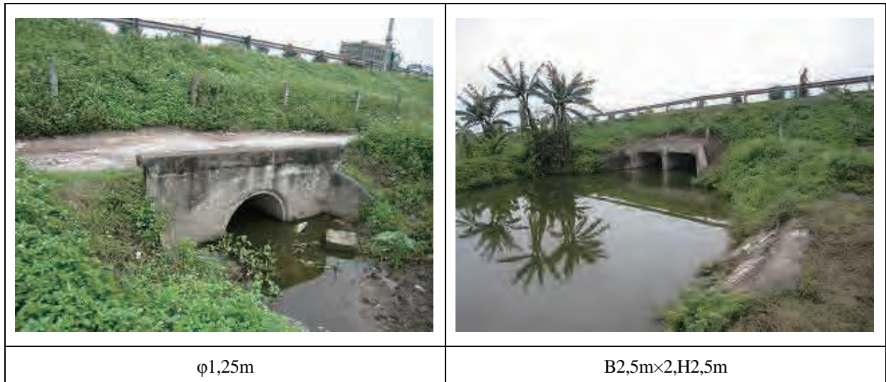
Hình 3.2.2-2 Cổng thoát nước tròn hiện hữu
