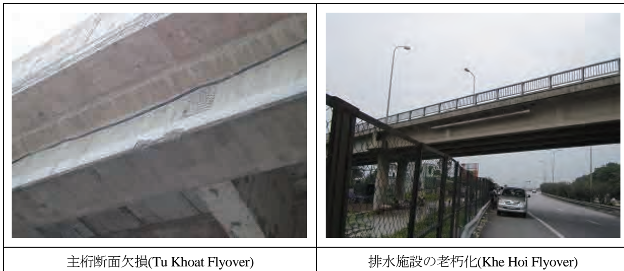
図 3.2.2-7 オーバーパスの現況
