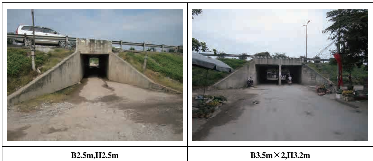
図 3.2.2-1 道路ボックスカルバート現況
