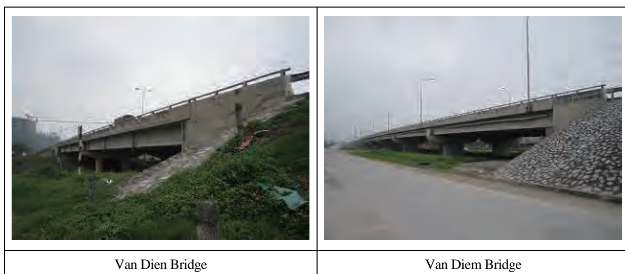
図 3.2.2-5 Van Dien Bridge および Van Diem Bridge の現況写真
