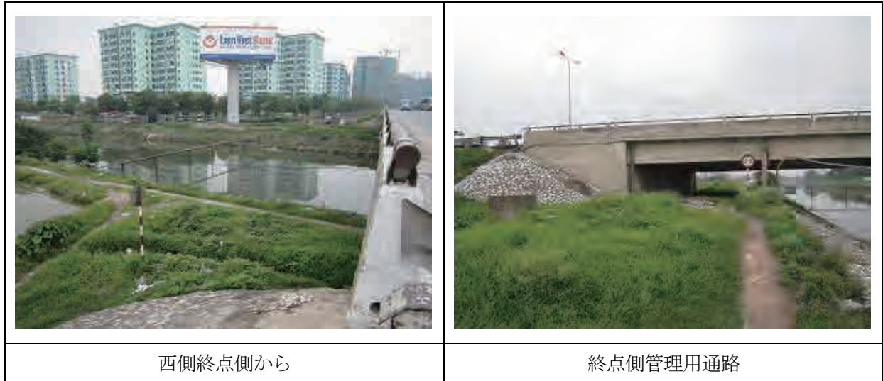
図 3.2.2-3 Van Dien Bridge
