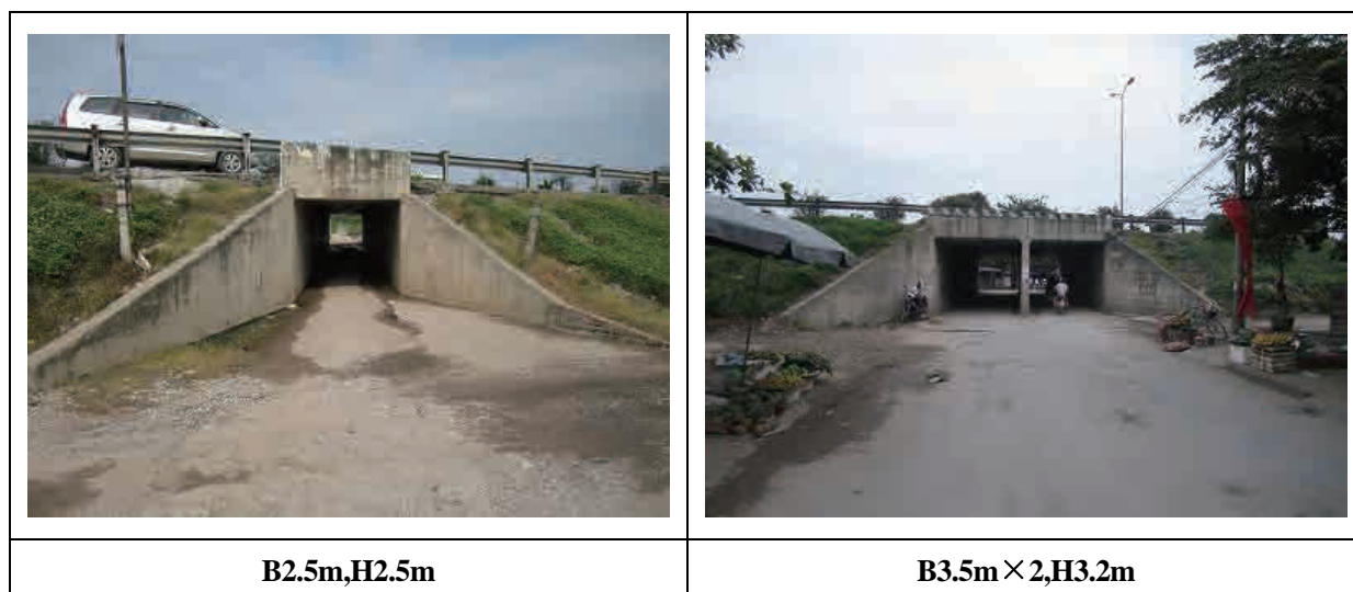
図 3.2.2-1 道路ボックスカルバート現況
