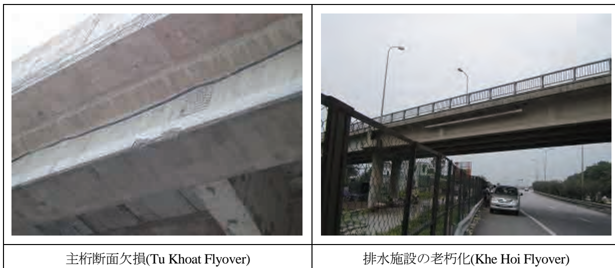
図 3.2.2-7 オーバーパスの現況
