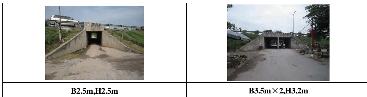
図 3.2-11 道路ボックスカルバート現況
