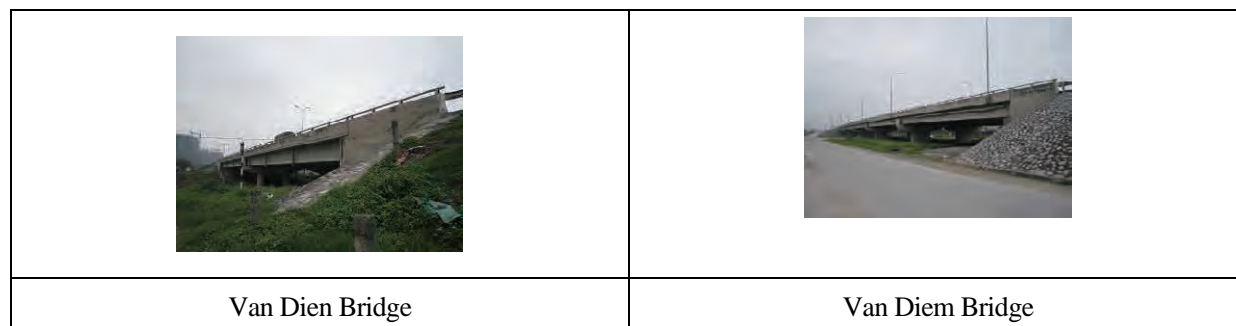
図 3.2-12 Van Dien Bridge および Van Diem Bridge の現況写真
